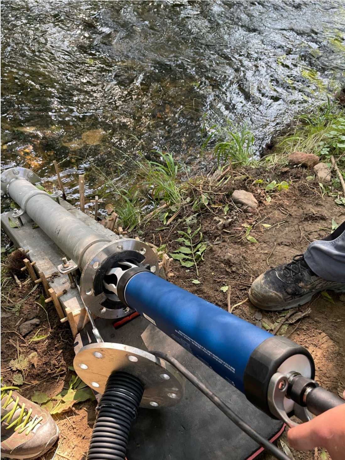
Einbau der Wasserqualitätssensoren
