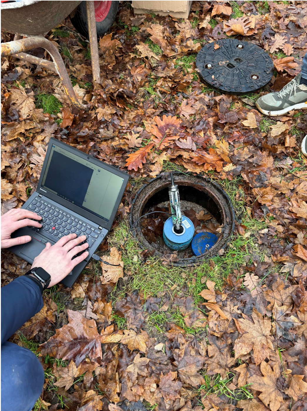
Einbau und Parametrierung Grundwassersonde
